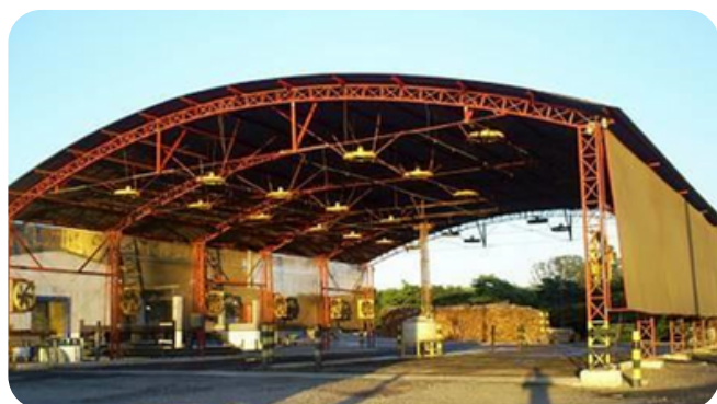
Figura 4.5. Galpões de chegada equipados com ventiladores laterais e aspersores de água superiores
