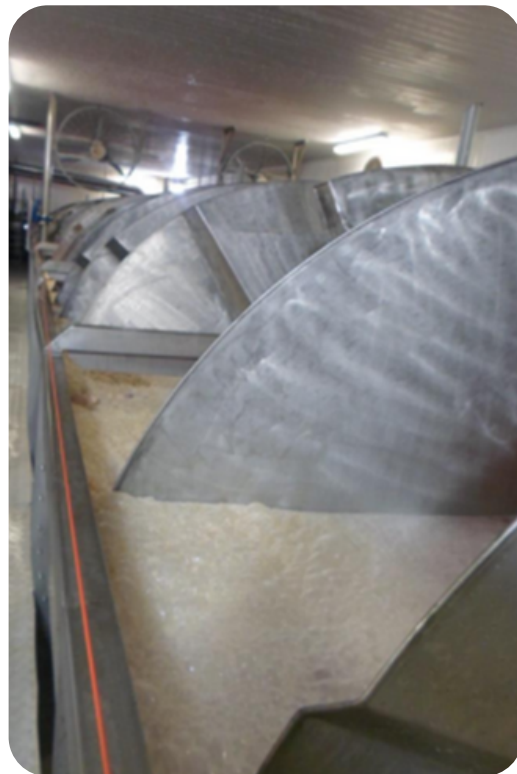
Figura 4.17. Chiller (tanque de pré-resfriamento do tipo rosca sem fim)
